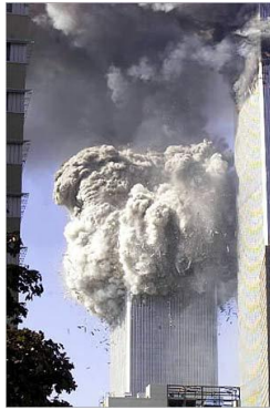
Разрушение башен ВТЦ
