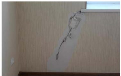
Примеры трещин, образовавшихся в зоне концентрации напряжений в угловых зонах оконных проемов
